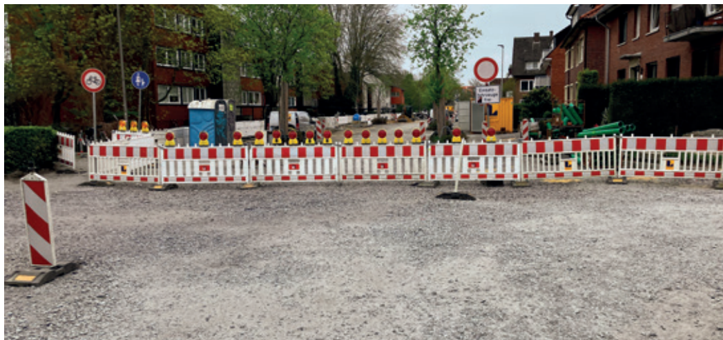
Der Umbau der Wilhelmstraße zur Fahrradstraße ist Teil umfangreicher Netz- und Kanalarbeiten © Stadt Münster
