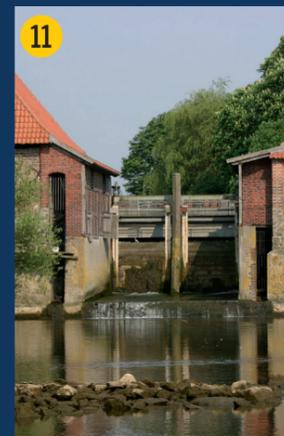
**Die Füchtelner Mühle** – malerisch und im Nebenfluss als kleines Wasserkraft-Werk genutzt. Durch den Bau einer Umflut ist hier 2015 die Durchgängigkeit der Stever für wandernde Fische wieder hergestellt worden.
